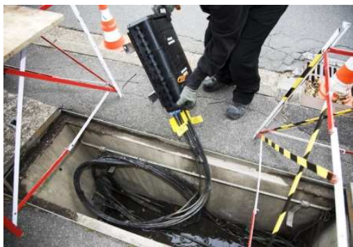
Raccordement dans la rue
